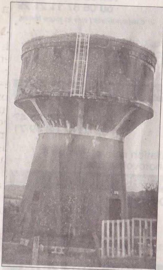
■ L'ancien château d'eau, rasé en 1999
